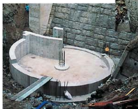
円形基礎にブロックを積載するための腰壁
