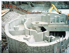
上部水路取付用の受ブロック
